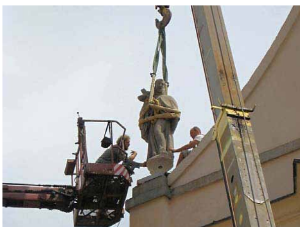
Instalace kopií původních barokních soch na štít kostela sv. Kláry na Františkánském náměstí v Chebu.
