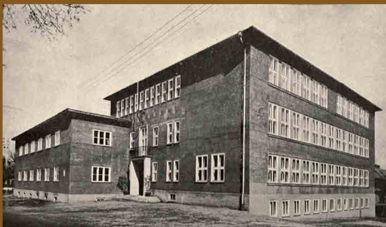
Budova německé Státní odborné školy pro zpracování dřeva (Staatsfachschule für Holzbearbeitung) v Kynšperku nad Ohří, 30. léta 20. století
